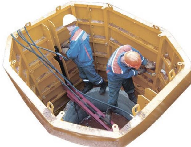
Уникальная вспомогательная система для прокладки новых и замены старых трубопроводов с последующим монтажом железобетонных колец без привлечения тяжелой техники.
