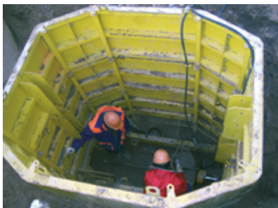
МНБ-50 в опалубке ОР-1,5
