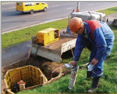
Работа МНБ-50 из опалубки ОР-1,5
