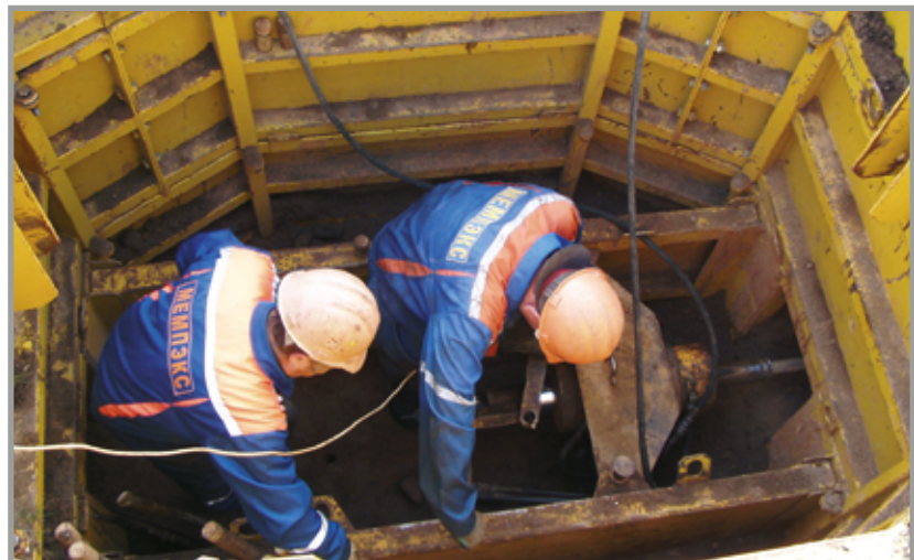
Замена трубы Д. 250 на Д. 315 мм по ул. Ташкентская (г. Минск)
