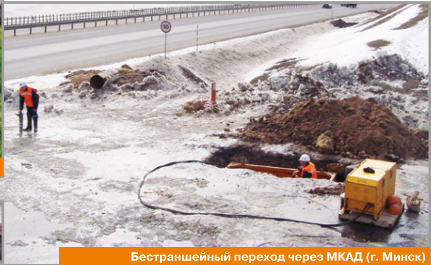
Работа МНБ-50 из опалубки ОР-1,5
