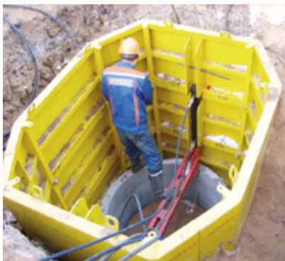
Строительство Ж/Б колодца
